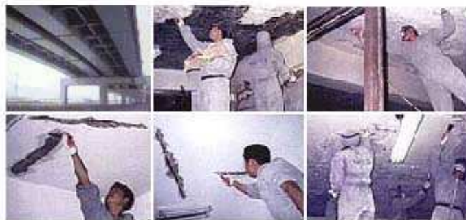
[그림 12] 단면복구공법의 시공 전경
