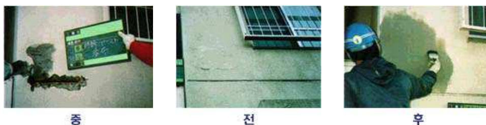
[그림 4] 표면처리공법의 시공과정
