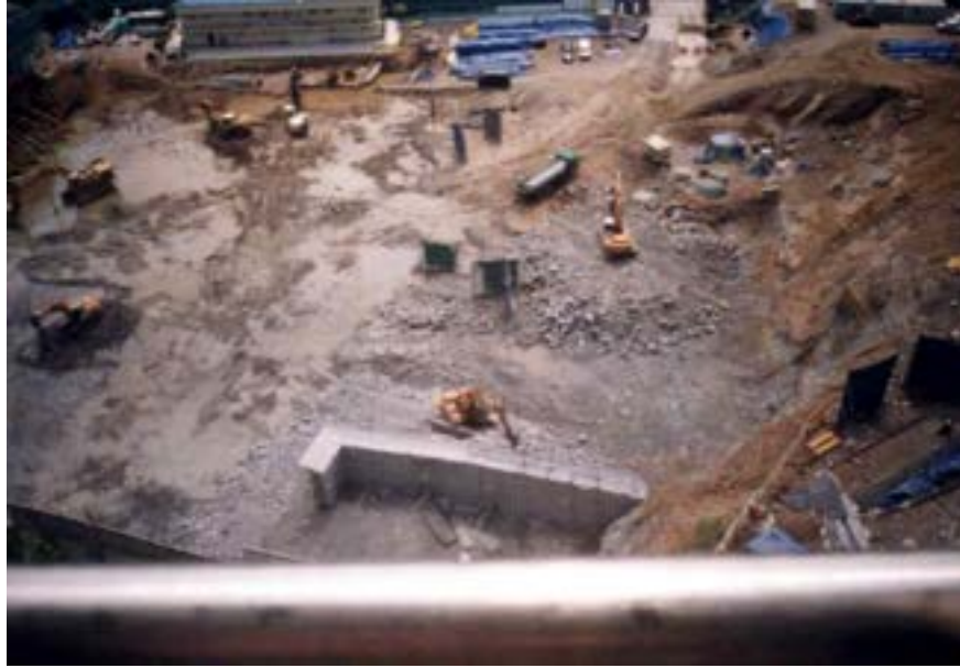
<그림 6.1> 건설기계의 분산배치 및 이동식 방음벽 설치 사례 (자료 : 한국건설안전기술원)
