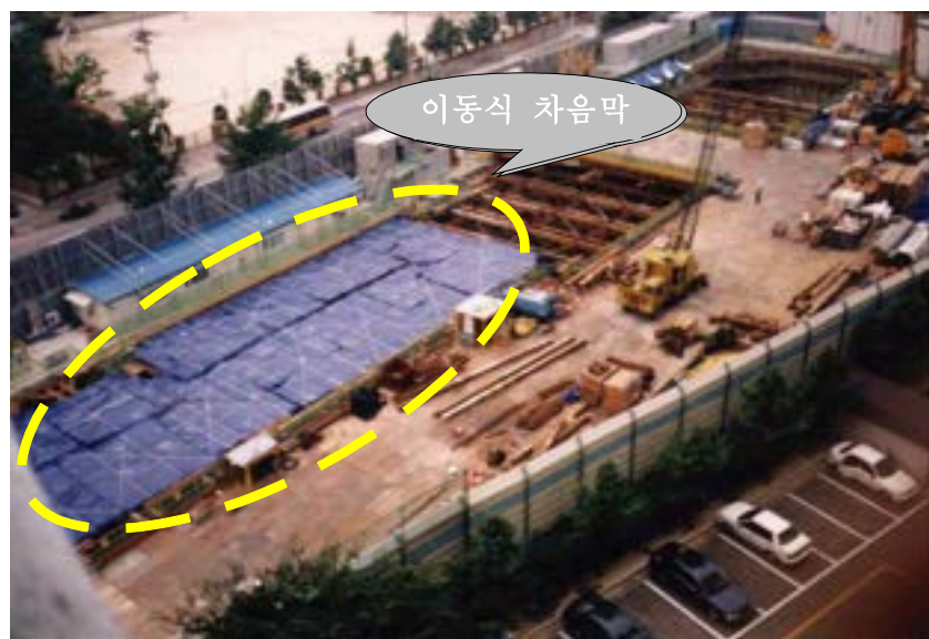
<그림 6.5> 암굴착 공사시 이동식 차음막 설치사례 (자료 : 한국건설안전기술원)
