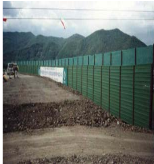
<그림 6.2> 가설 방음벽 설치사례 (자료 : 한국건설안전기술원)
