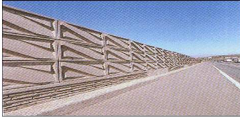
(c) 콘크리트 방음벽
