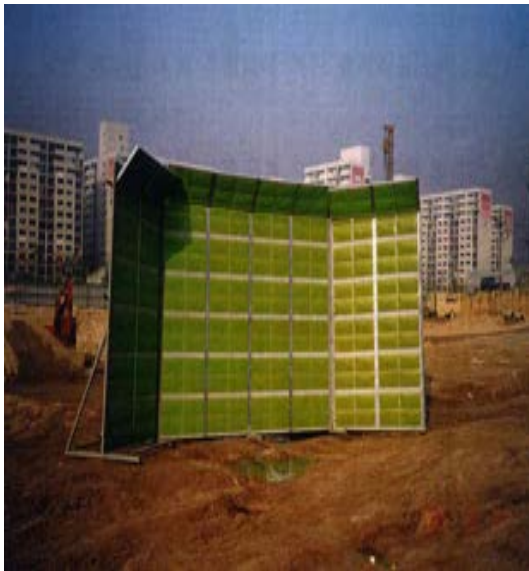
<그림 6.2> 가설 방음벽 설치사례 (자료 : 한국건설안전기술원)
