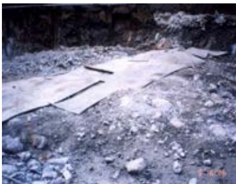
(c) 비산방지용 방호매트 설치전경
