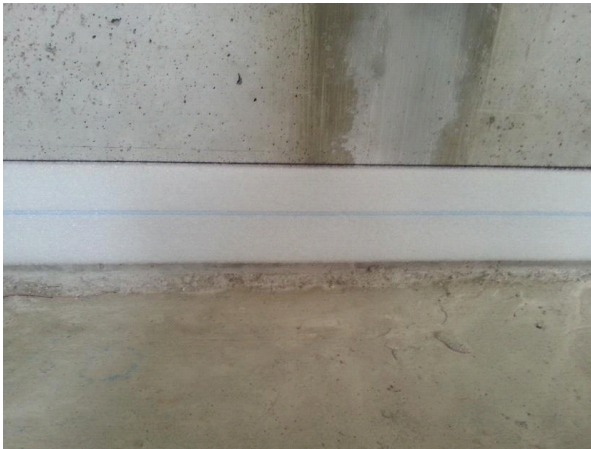
측면완충재 부착 시 마감 모르타르 하단부착
