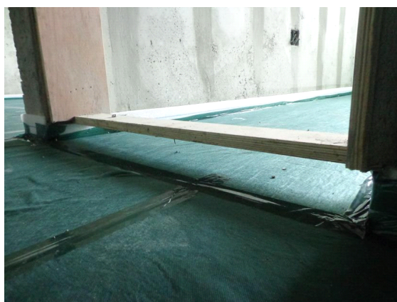
문틀하부 바닥완충재 밀실시공
