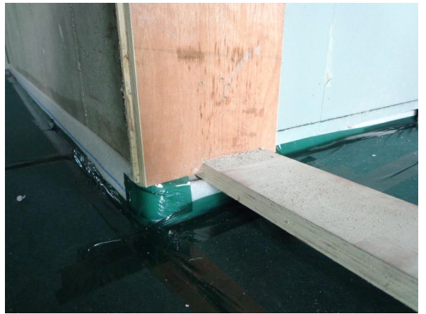
가틀 하단부 측면완충재 시공
