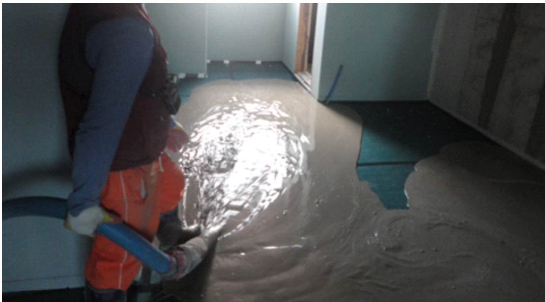
<그림 4-16> 경량기포 콘크리트 시공모습
