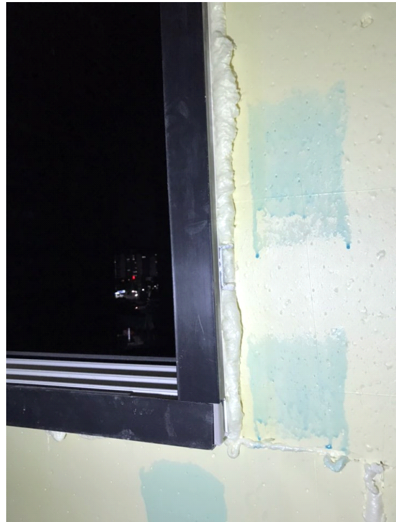
틈새가 밀실하게 시공된 창호
