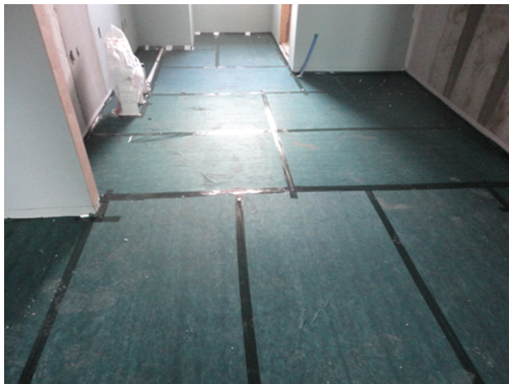
<그림 4-11> 완충재 설치모습
