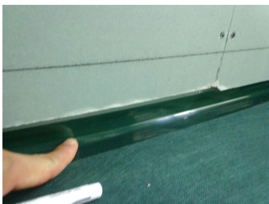
바닥완충재와 벽체 접합부 테이핑처리
