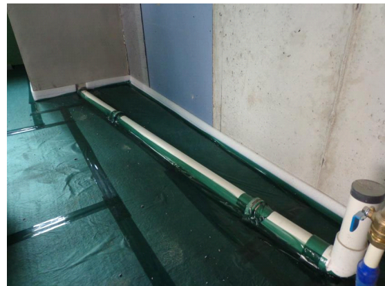
배관부위 완충재 시공
