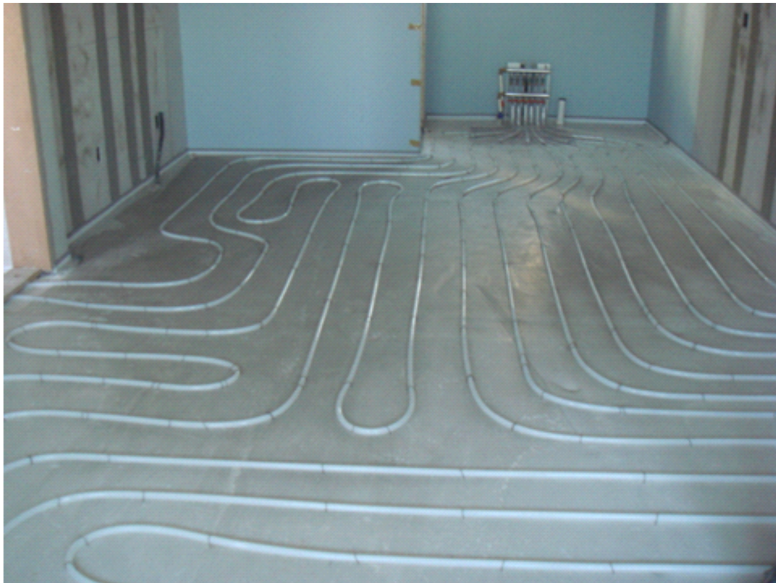
<그림 4-17> 난방 배관 설치모습
