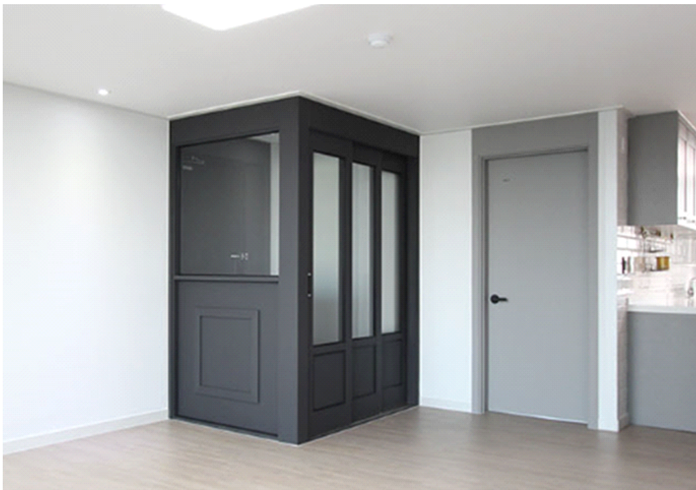
<그림 5-3> 공동주택 현관 중문 설치의 예
